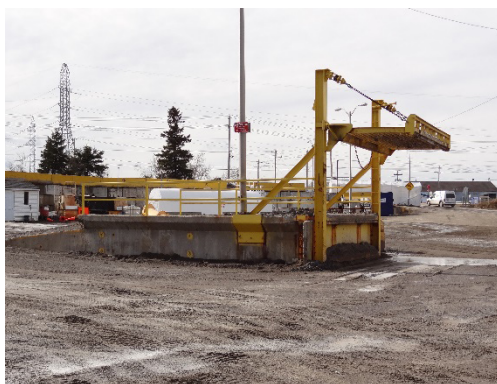
Photo 17 – Rampe de chargement avec grille de tamisage
