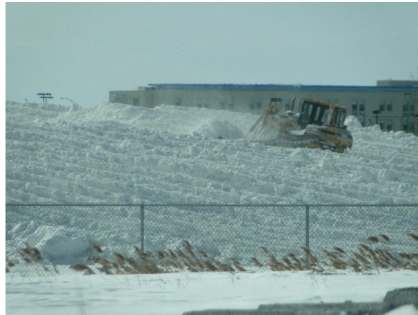
Photo 5 – Mise en pile d'un dépôt à neige avec boteur
