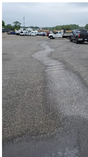
Photos 13 et 14 – Trace de ruissellement et de sédimentation de sels de voirie à l'extrémité sud-est de la cour de l'atelier de Gatineau
