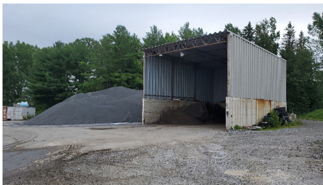
Photo 16 – Entreposage de sels de voirie et d'abrasifs à l'atelier de Buckingham
