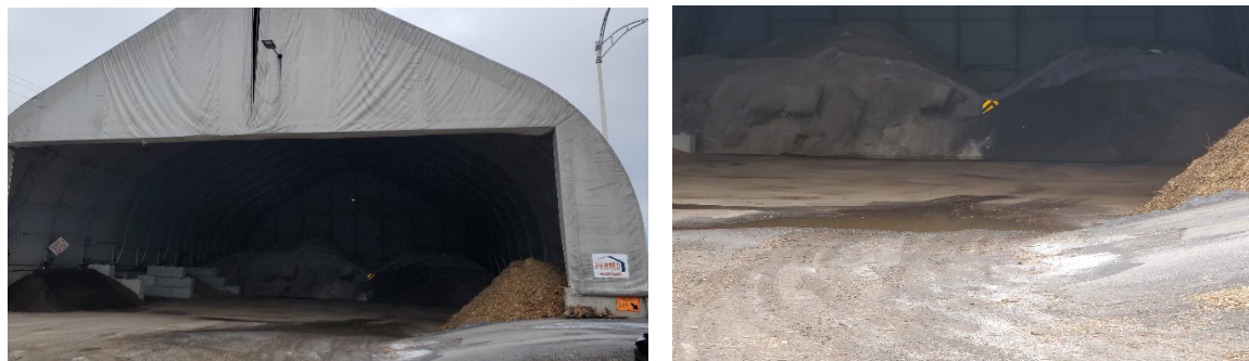
Photos 9 et 10 – Entrepôt couvert de l'atelier de Hull
