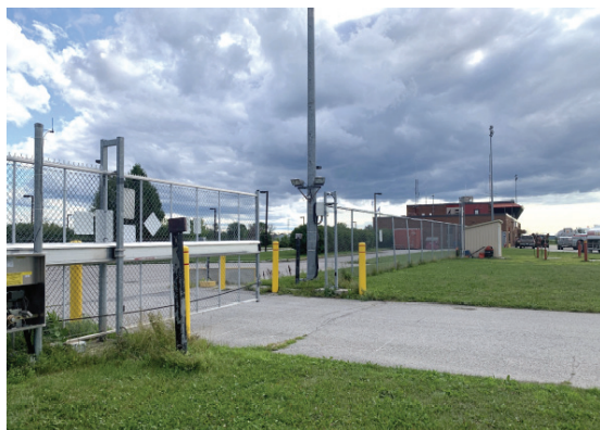
Photo 4 : Le système de motorisation de la barrière a pu être désactivé manuellement et la clôture a pu être ouverte, donnant ainsi accès au site
