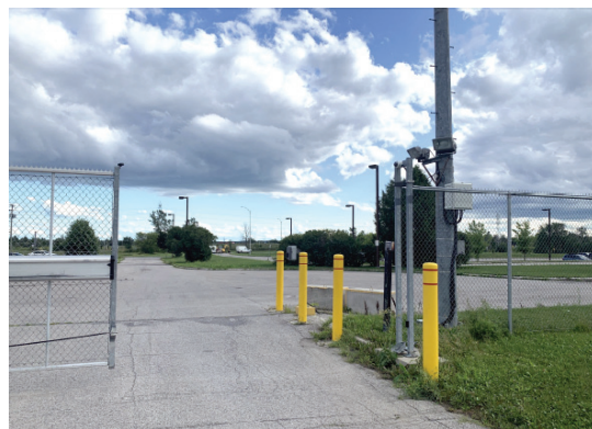
Photo 5 : Clôture ouverte manuellement en contournant le système de motorisation qui en sécurise l'ouverture
