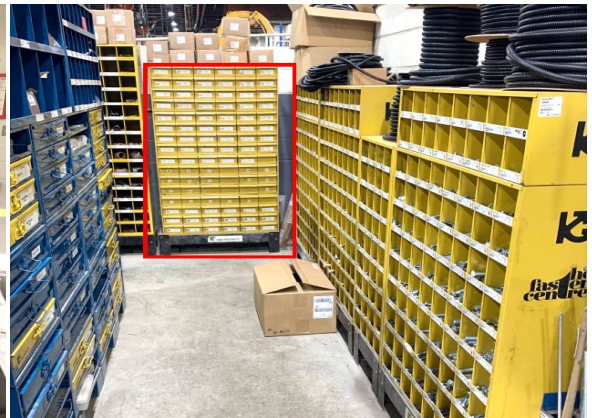
Photo 7 : Atelier de Hull – raccords à air gardés en atelier avec un accès en libre-service
